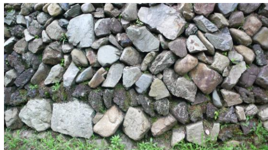
石垣に積み込まれた鉄滓
