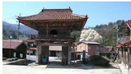
浄蓮寺鐘楼門
