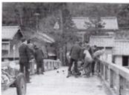
仮収蔵庫前の波佐大橋で消防放水訓練
