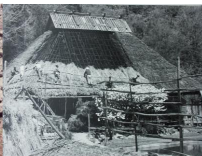
屋根葺き替え作業
