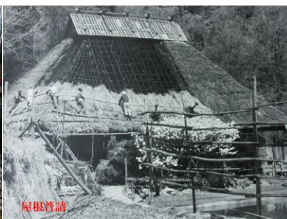
民家の屋根葺き替え作業
